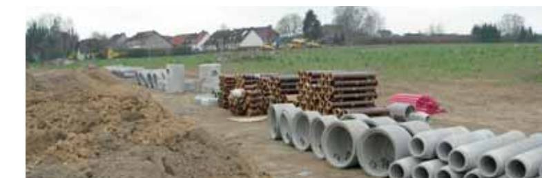
Straßen- und Tiefbauarbeiten im Neubaugebiet Wittenberger Feld
