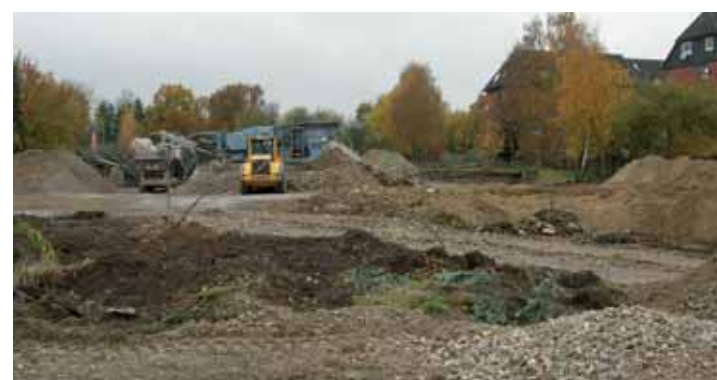
Abriss der ehemaligen MAN-Gebäude an der Glüsinger Straße
