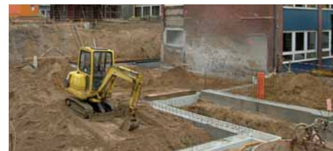
Gründungsarbeiten des Anbaus an die GHS in Meckelfeld
